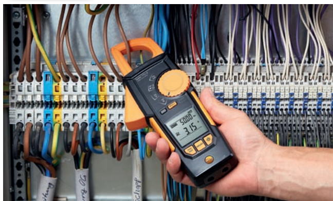
Измерение силы тока в распределительном щитке
