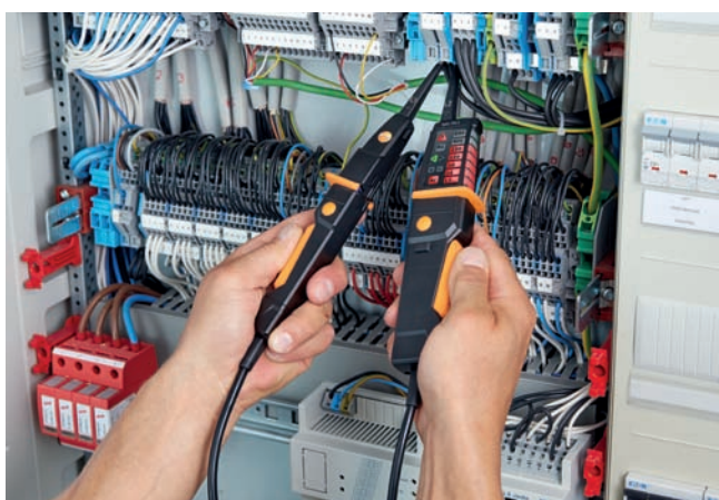
Измерение напряжения в распределительном щитке
