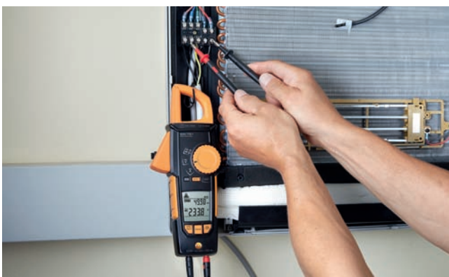
Измерение напряжения на блоке кондиционера с testo 770
